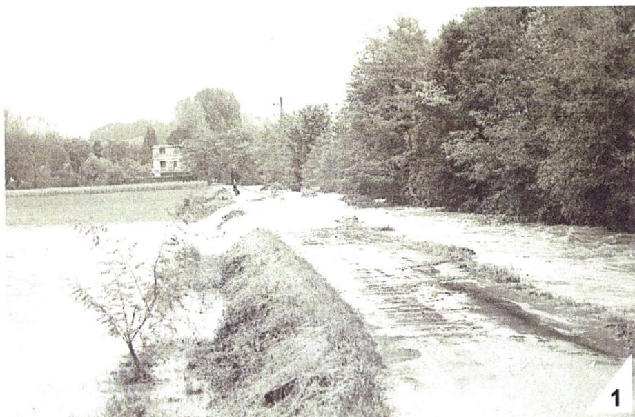
1 St Jean de Soudain : débordements de la Bourbre par dessus la digue rive droite, sans rupture, en amont de la RD 1.
