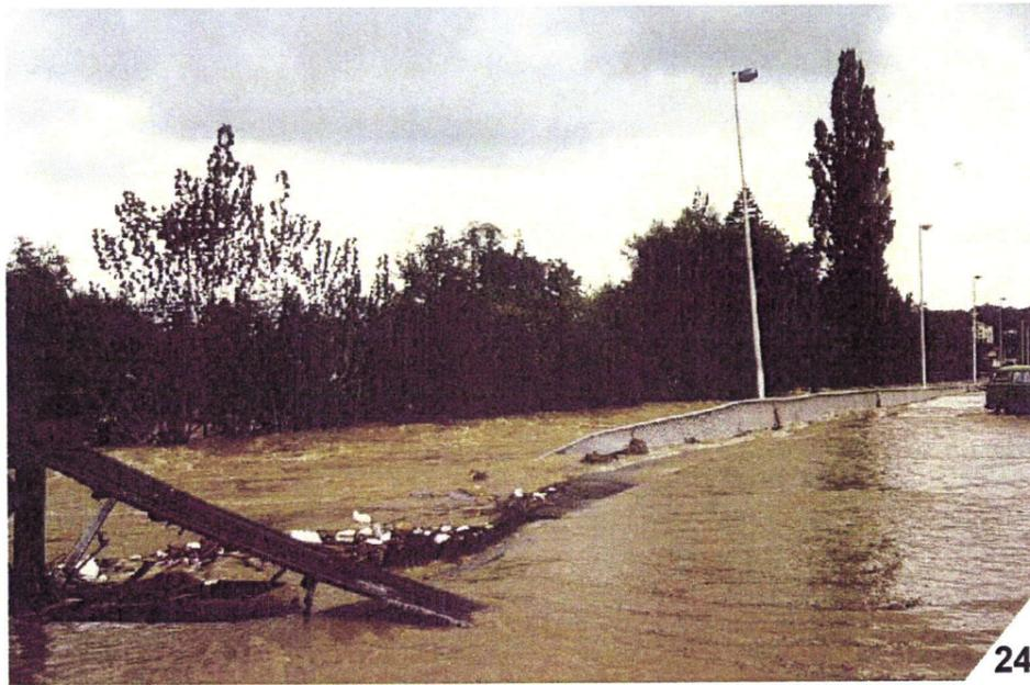
24 - Affaissement du quai de la Bourbre en amont de la passerelle des Pivollets.
