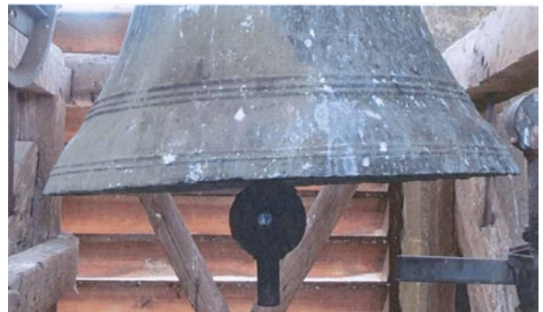
La cale en bois placée entre le joug et la cloche est de travers ce qui fait que la cloche n'est pas d'aplomb et le battant tape de travers.
